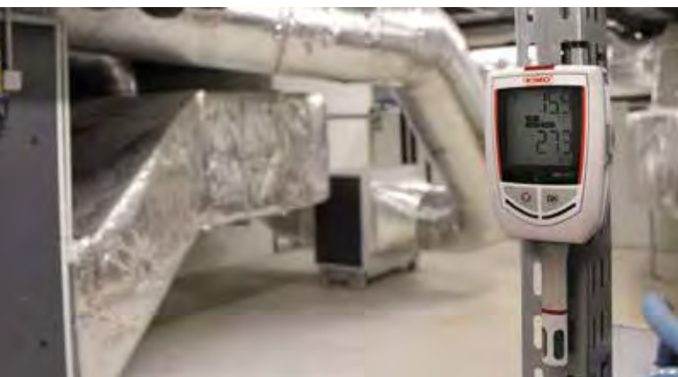
KH 220 aimanté dans le local de traitement d'air d'une infrastructure industrielle
