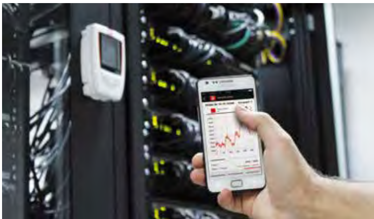
Contrôle des données climatiques d'un datacenter à l'aide de l'application pour smartphone.
